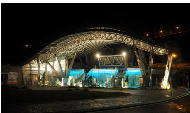
stazione di valle
