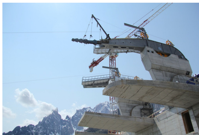
stazione di monte – cantiere
