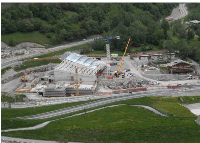
stazione di valle - cantiere
